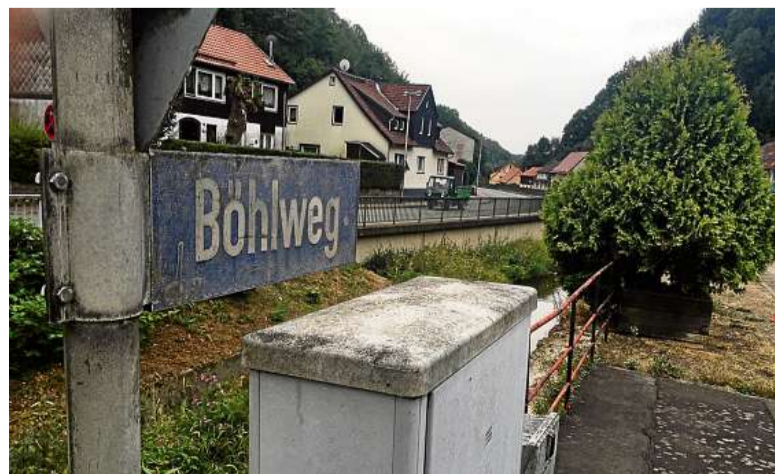
Der Bohlweg in Wieda soll mit Mitteln aus dem Dorfentwicklungsprojekt saniert werden.
