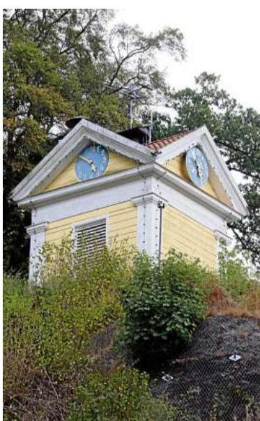
Der Glockenturm muss saniert werden.
