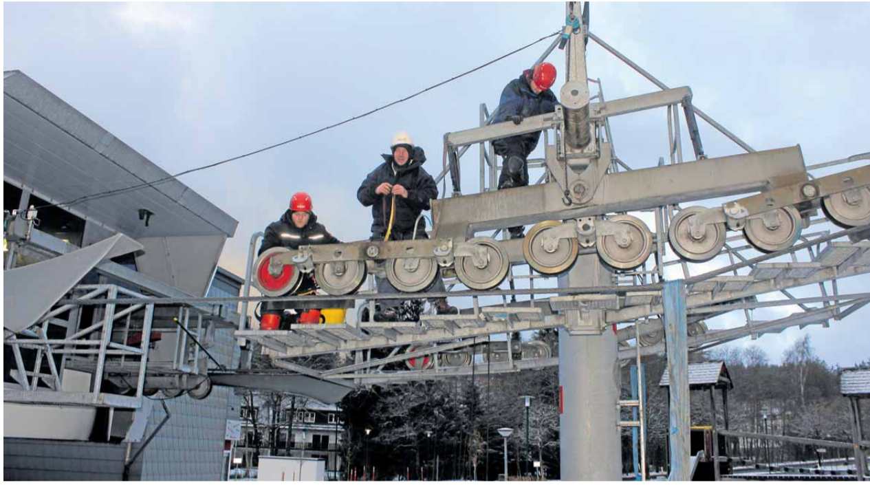
Max Rieche, Bernd Nette und Amer Kajevic kümmern sich auf Stütze 1 um die Rollen und Wippen.
