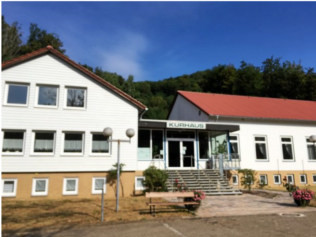
Das Kurhaus in Wieda benötigt vor allem im Bereich der Elektrik eine grundlegende Sanierung.
