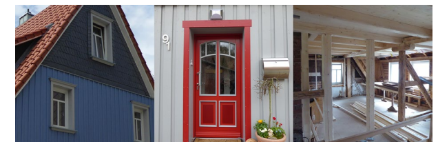
Beispiele: Fassade, Haustür, Innenausbau/Revitalisierung
